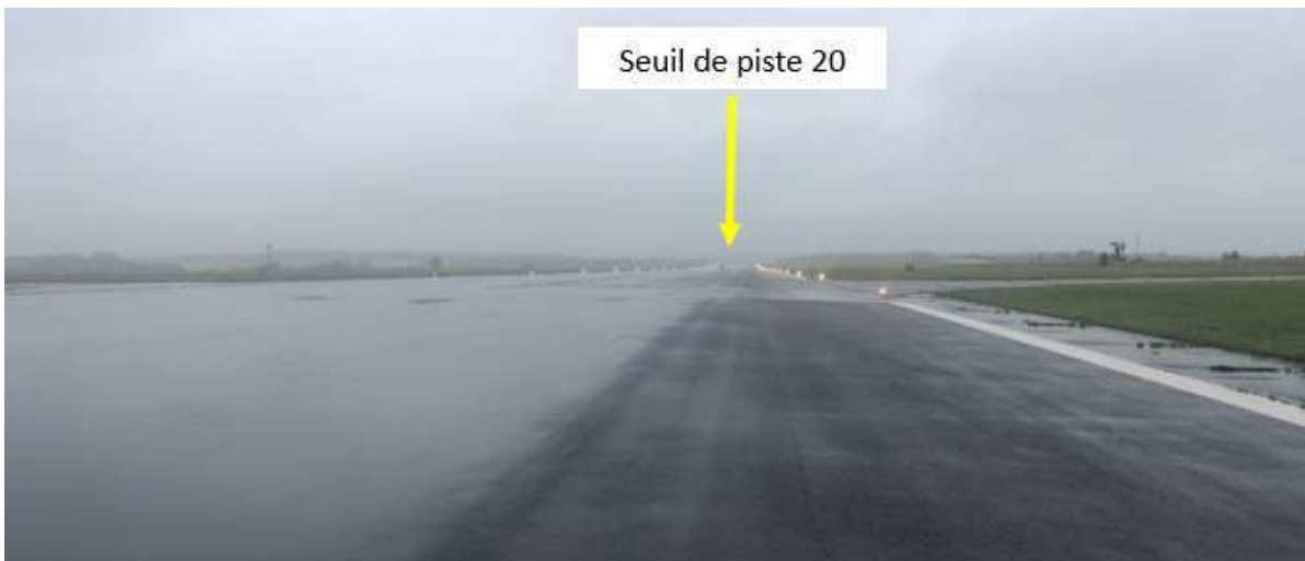
Figure 8 : piste recouverte d'eau sur la trajectoire de l'aéronef (10 mn après l'évènement)
