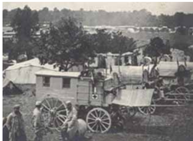
Ambulance chirurgicale des premières lignes à Baleycourt, secteur de Verdun 1916.
